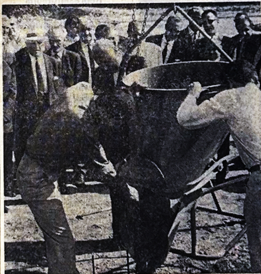
Sous l'œil de M. Duffaut, première coulée de béton du stade !
